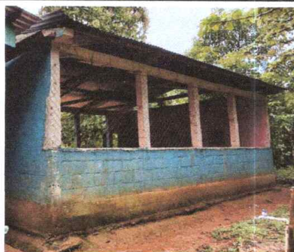
Foto 4: Se Evidencia el lugar donde de instalaran los balcones.
